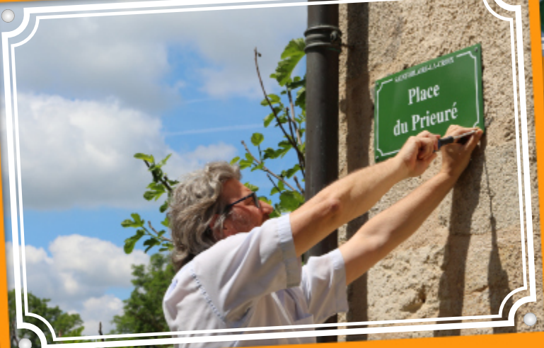
Pose des premières plaques de rues
