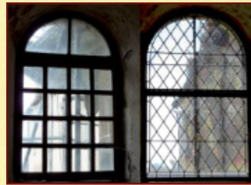
d'un simple châssis de bois vitré devenu hors d'usage. Celui-ci a été remplacé par un vitrail losangé très clair avec la partie inférieure ouvrante pour faciliter l'aération de l'église.
